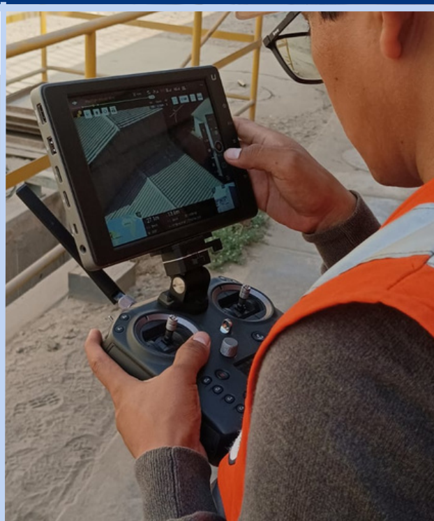
Inspección de techo con Dron
