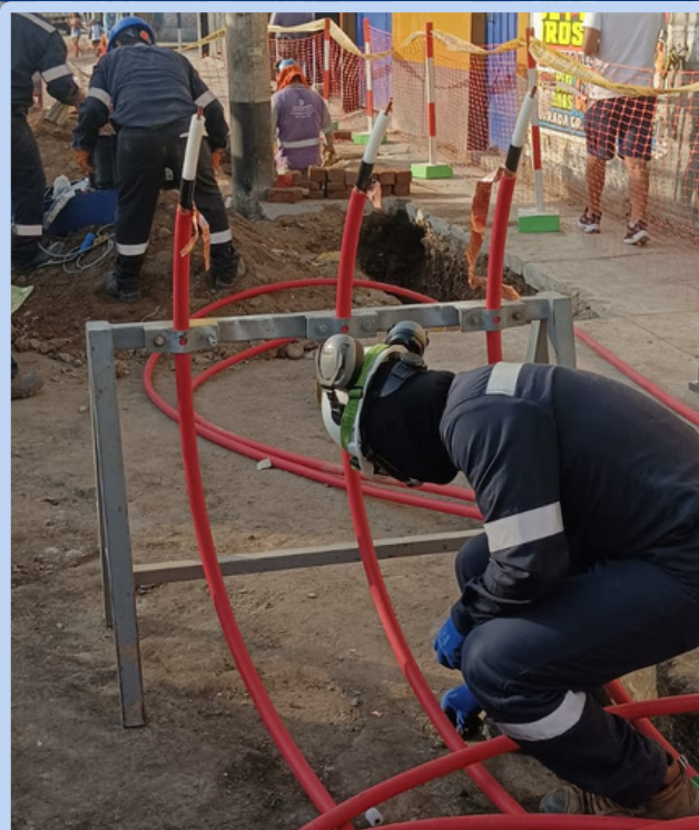
Tendido de cables
