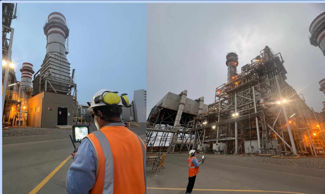
Inspección termográfica en chimeneas de calderas en centrales termoeléctricas
