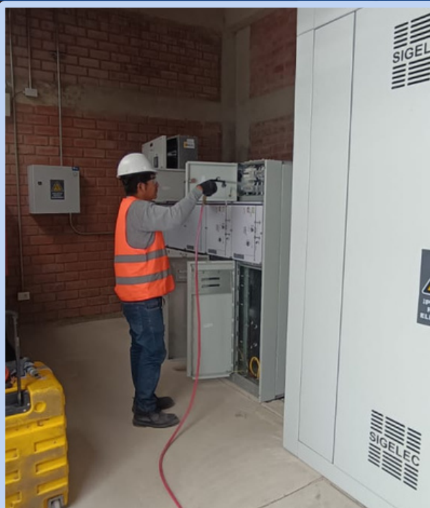
Mantenimiento de Subestación
