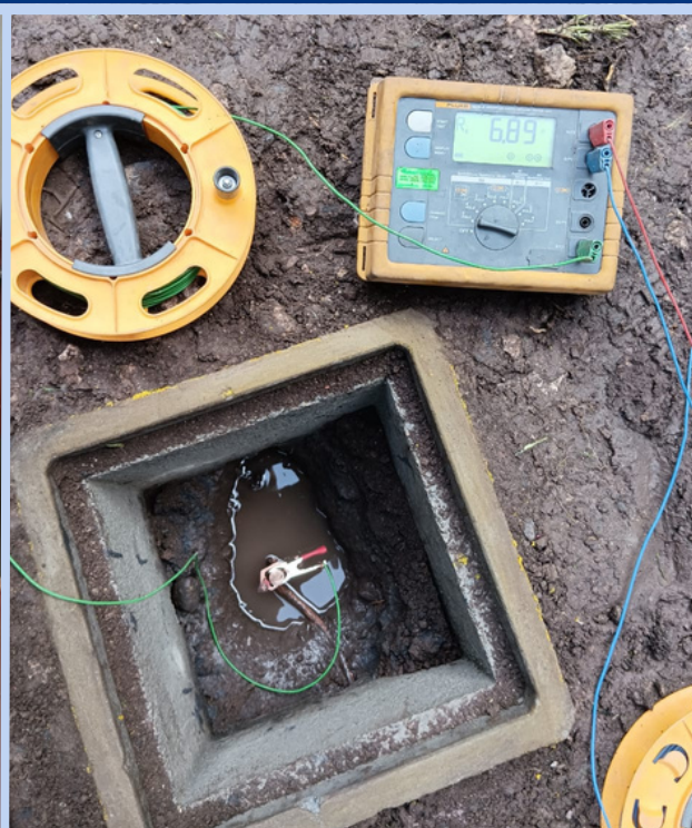
Mantenimiento y medición de sistemas de puesta a tierra
