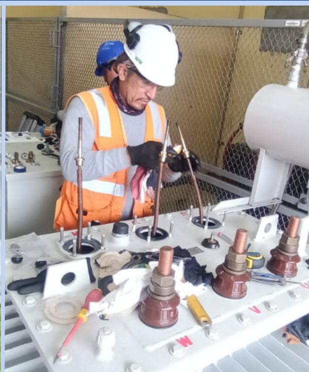
Cambio de empaques a transformadores de potencia
