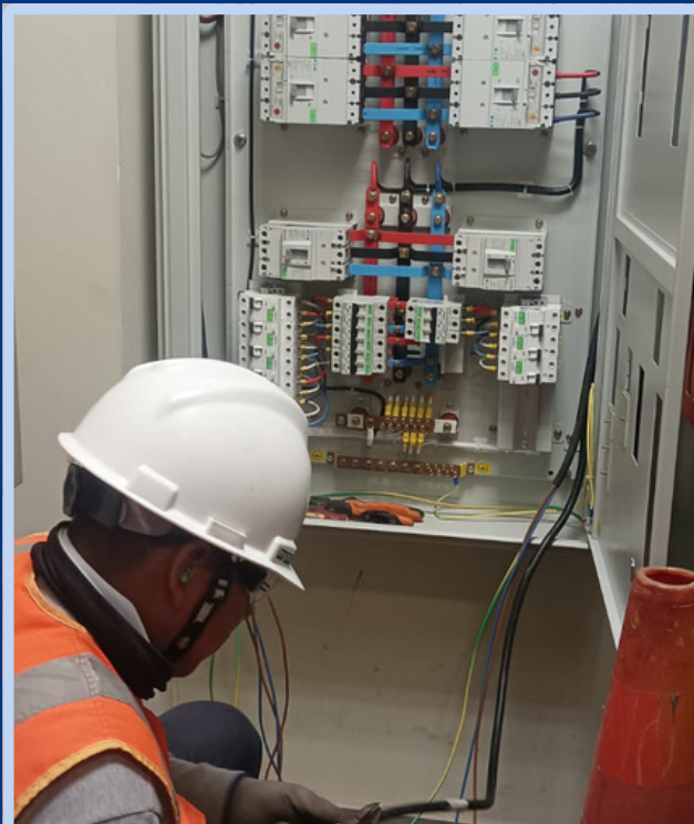
Instalación de tableros de baja tensión
