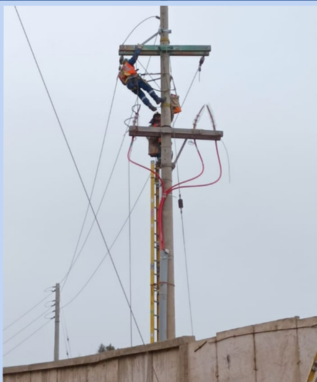
Mantenimiento en líneas de transmisión
