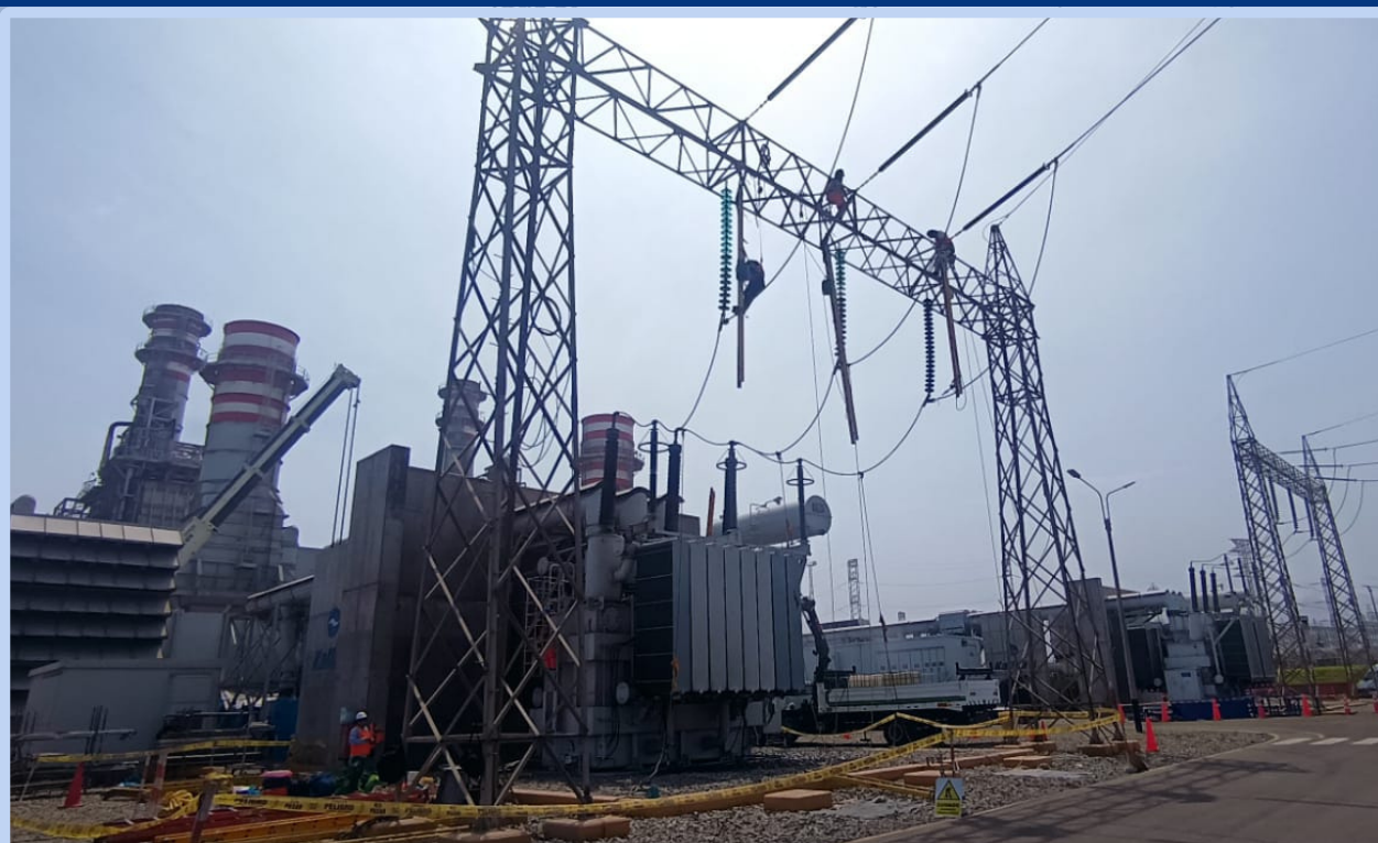
Mantenimiento de líneas de transmisión en central termoeléctrica
