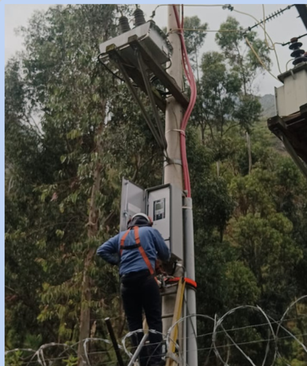
Mantenimiento de Línea
