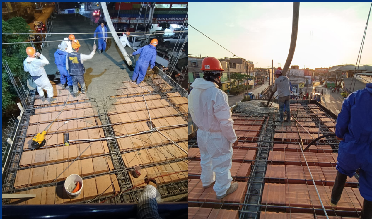
Vaciado de Losa
