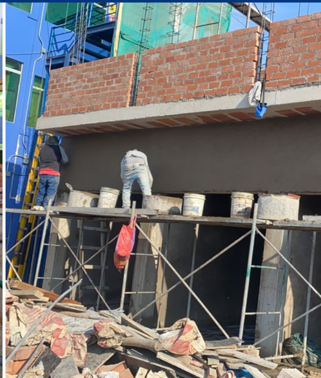
Trabajos de vaciados y tarrajeos
