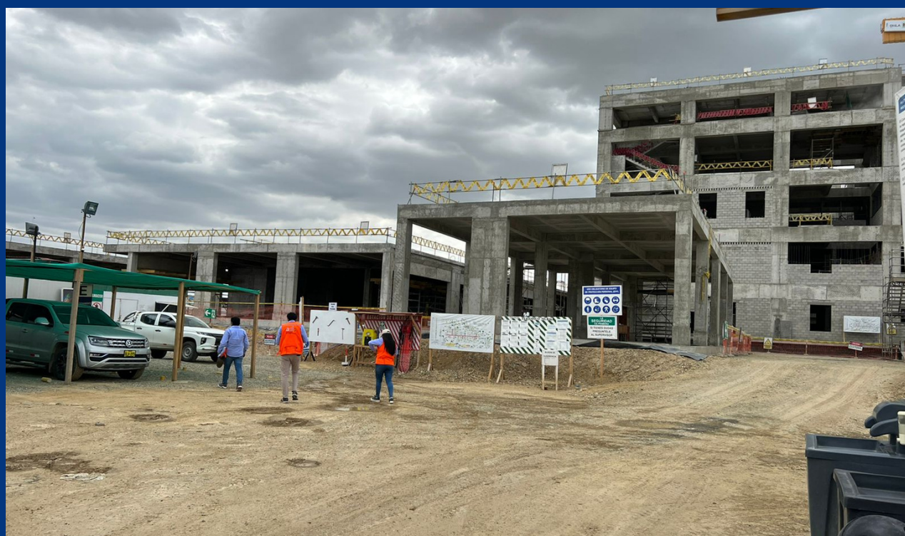
Contrucción de Estacionamientos
