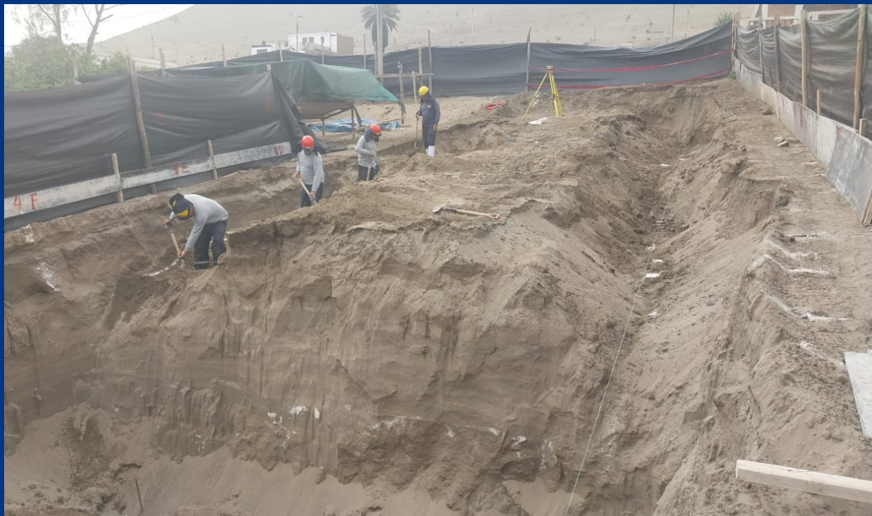
Nivel, trazo y Replanteo
