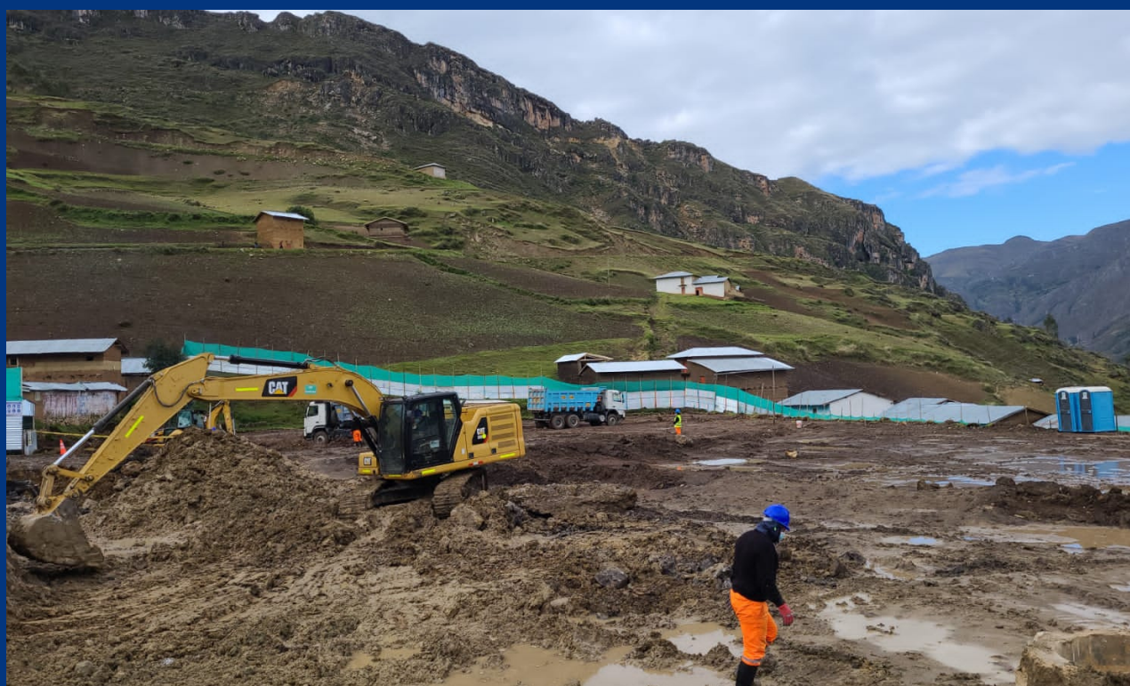
Excavación y Relleno
