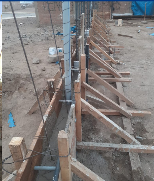
Encofrado para cimentación
