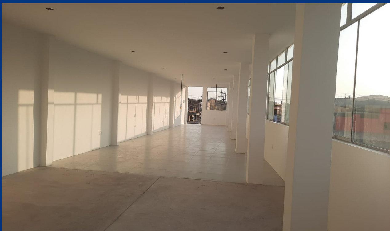
Trabajos en acabados y pintura
