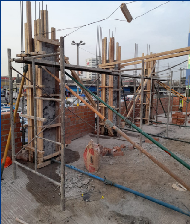
Trabajos de Encofrados
