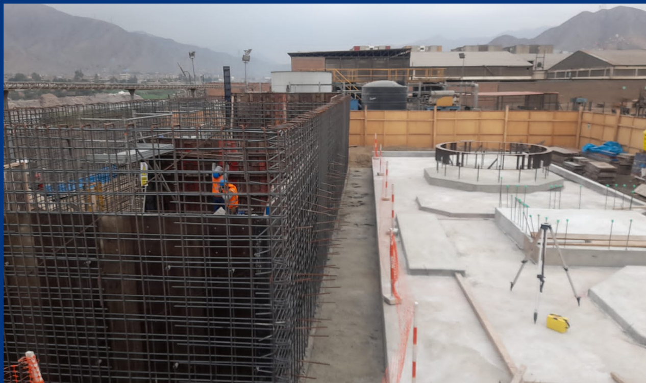
Armado de placas
