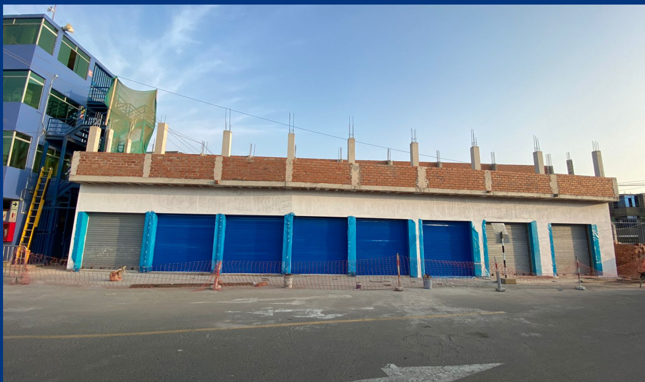
Construcción de Modulos de ventas
